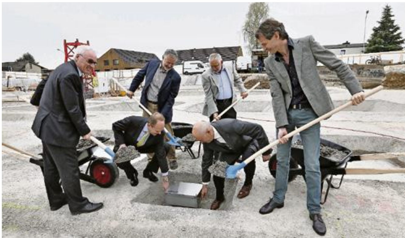
Vertreter der Gemeinde, der Genossenschaft WSGZ und des Generalunternehmens Allreal legten den Grundstein. Bild: Sibylle Meier
